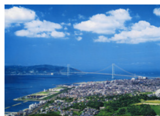
兵庫-039 明石海峡大橋 4992617425986
