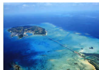
沖縄-088 宮古島池間大橋 4992617424651
